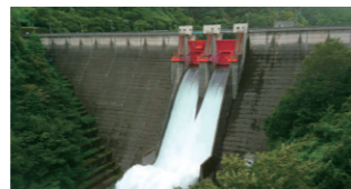
災害を未然に防ぎ、地域を潤すダムの管理を!
